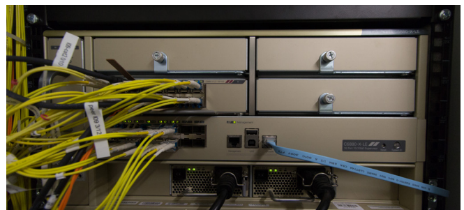
Abb.: 03. Core-Switch des ZIM
